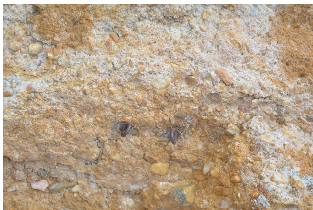
Fig. 5: Pernos de hierro utilizados en la intervención de 1962. Fuente: Autor del trabajo.
